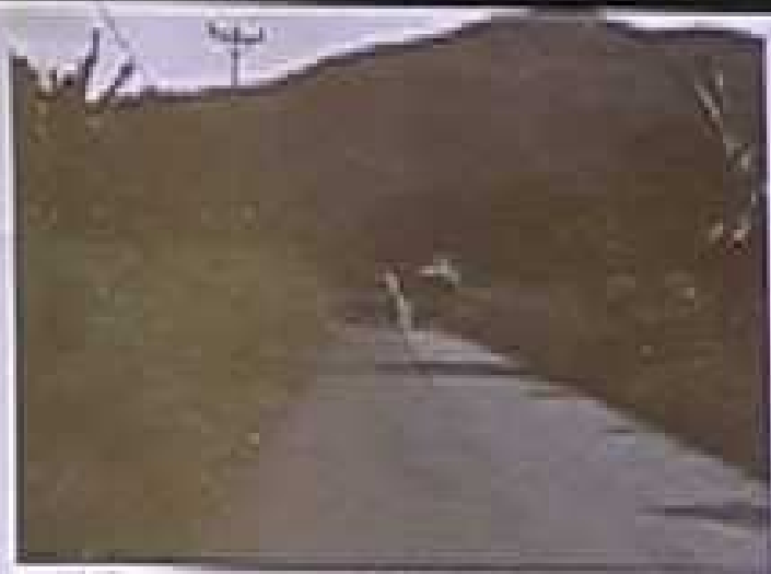
国道A02号線、長針な路盤であるが幅員が狭い
